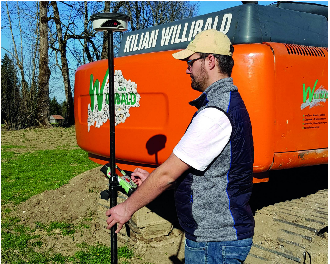
Auf stabile Datenverbindung angewiesen – Christoph Willibald bei der Vermessung am Bau
