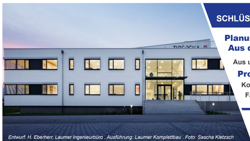
Entwurf: H. Eberherr, Laumer Ingenieurbüro . Ausführung: Laumer Komplettbau . Foto: Sascha Kletzsch
