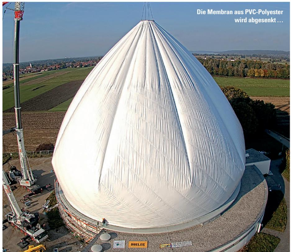
Die Membran aus PVC-Polyester wird abgesenkt ...
