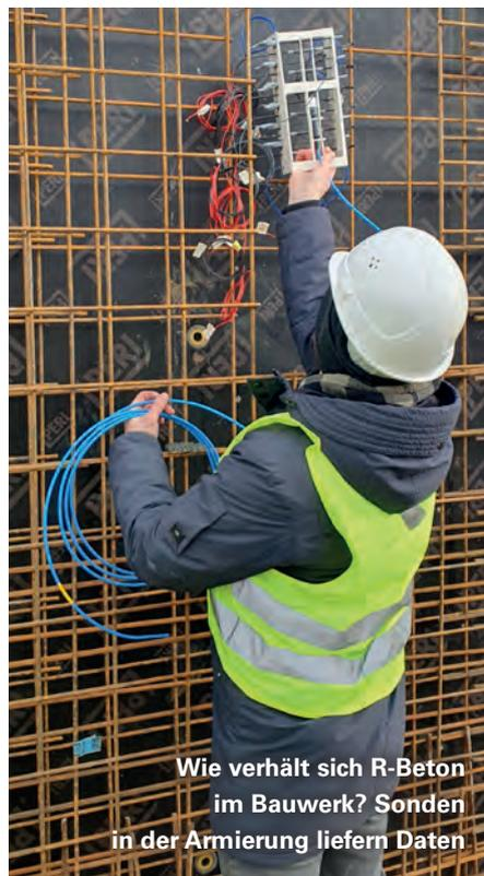
Wie verhält sich R-Beton im Bauwerk? Sonden in der Armierung liefern Daten
